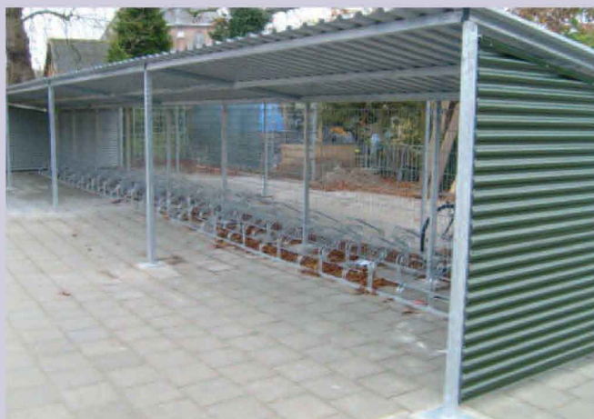
B-50 geprofileerde staalplaat
