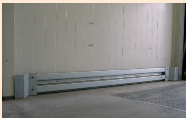
Vangrail B-profiel met speciale hoeken
