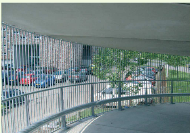
Buisconstructie met leuning
