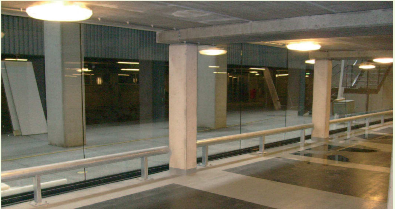
Buisconstructie in parkeergarage
