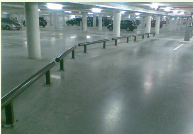
Buisconstructie met leuning
