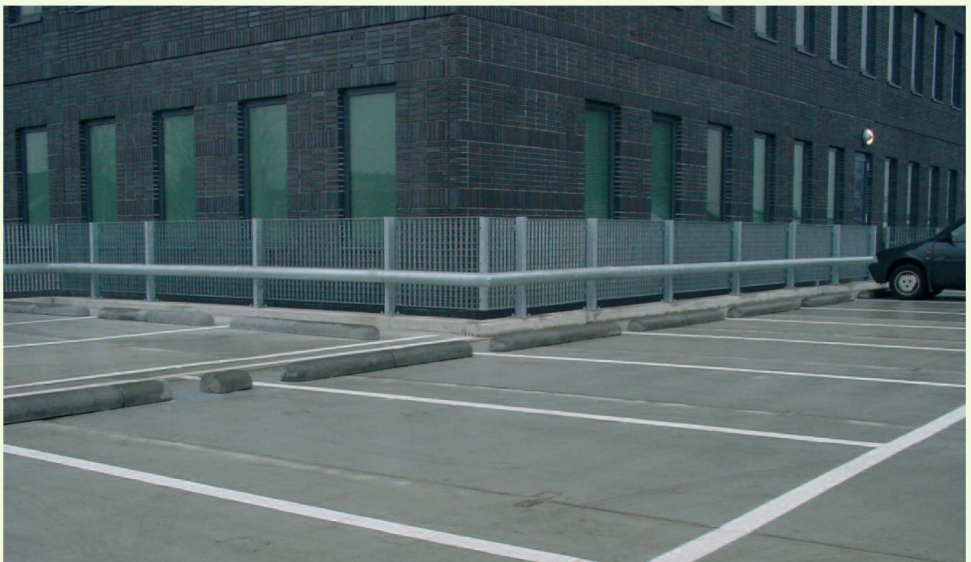
Buisconstructie met hekwerk
